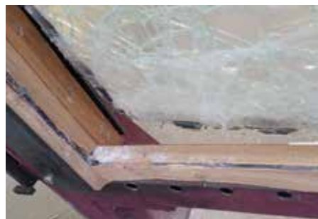
Immagine 2: Taglio e rimozione del telaio in legno.
